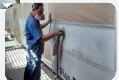
Técnicas de lixamento para um melhor acabamento da pintura com uso correto de EPI - Equipamentos de Proteção Individual
