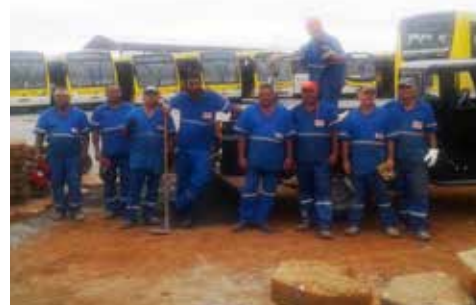
Para aumentar a segurança, muito empenho da equipe na reforma do calçamento do pátio
